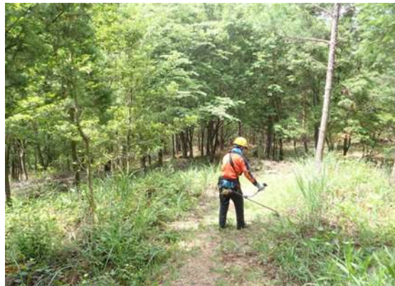
▲JR 西日本西条駅班は、「桜の広場」東斜面で刈り払い機を使って広域に作業
